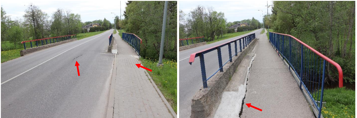
7 pav. Pėsčiųjų ir dviratininkų tako deformacijos
