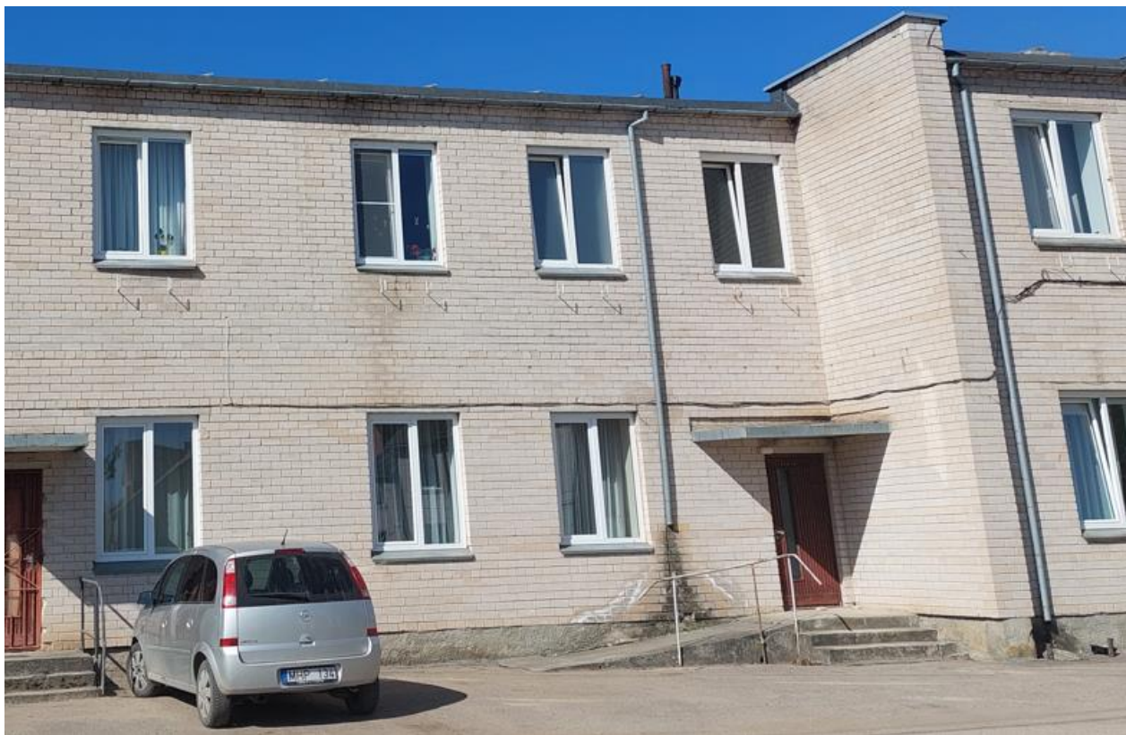
4 pav. pastato vieta kur projektuojami rekonstravimo darbai
