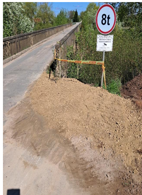
Skalda užpilta šalia Švobiškio tilto atsiradusi įgriuva
